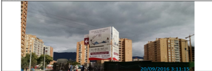
FOTOGRAFIA 2: vista panorámica de Elementos tipo valla de obra instalados en el predio ubicado en la calle 134 No 55 - 32, el cual no cuenta con registro ni impresión de la información de la curaduría
